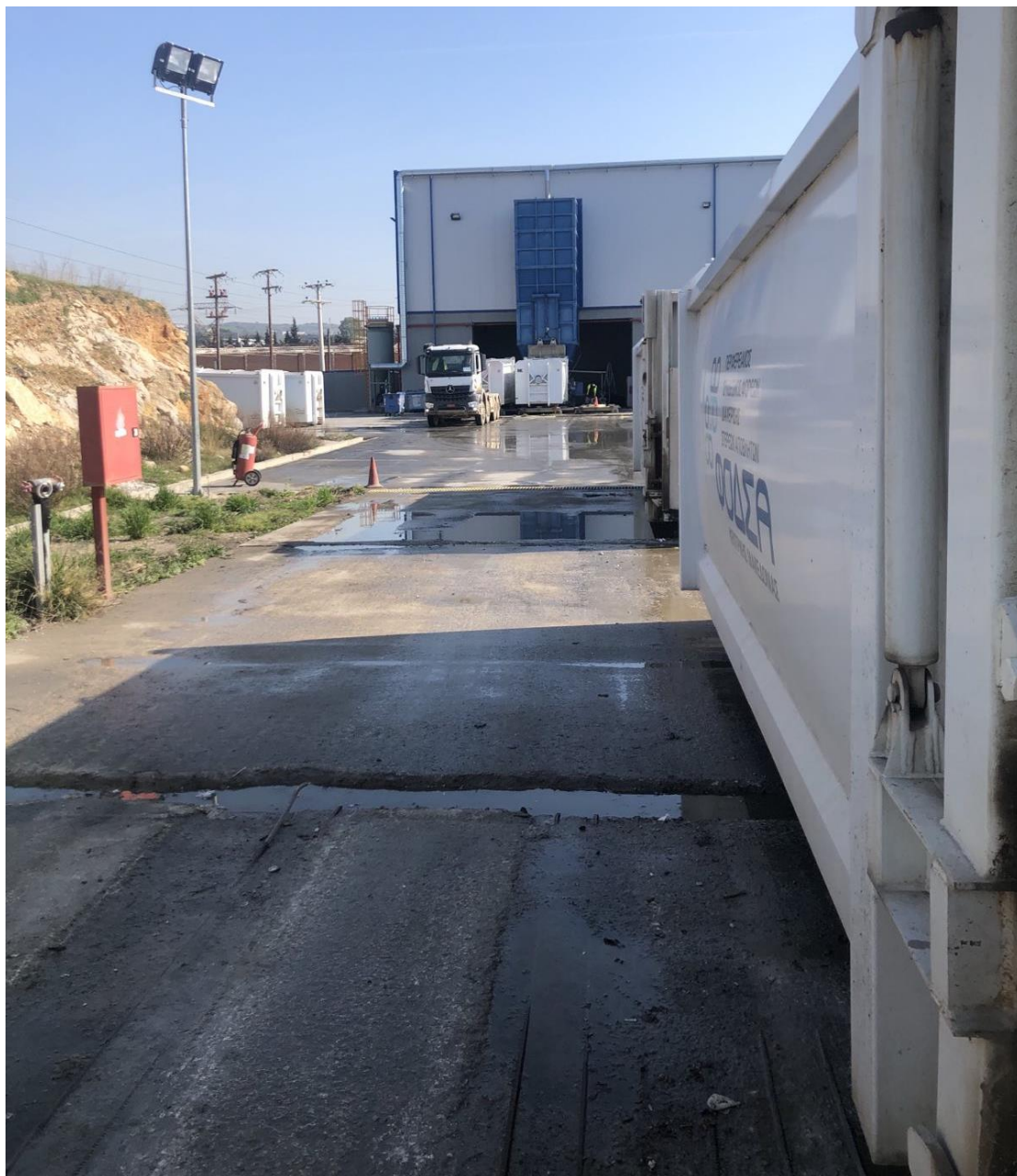
Εικόνα 2.7 Λήψη επί της πλάκας έδρασης των container. Διακρίνονται εκτεταμένες βλάβες στην επιφάνεια της πλάκας, όπως είναι η εμφάνιση του σπλισμού της άνω παρειάς της, λιμνάζοντα επιφανειακά ύδατα (στραγγίσματα & όμβρια ύδατα) που δεν απορρέουν φυσικά, διεύρυνση των αρμών συστολής και διάφορες επιφανειακές ανωμαλίες.
