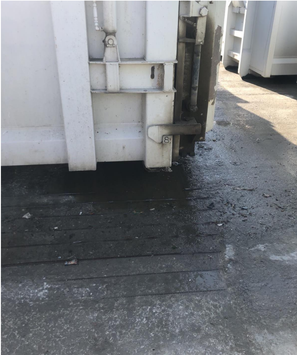
Εικόνα 2.9 Λήψη επί της πλάκας έδρασης των container στη θέση όπου λαμβάνει χώρα η διαρροή των στραγγισμάτων από αυτά. Διακρίνεται η αποκάλυψη του οπλισμού της άνω παρειάς της πλάκας που είναι εντονότερη πλησιάζοντας προς τη θέση διαρροής, αποδεικνύοντας την επικινδυνότητα του φαινομένου και την ανάγκη λήψης μέτρων αντιμετώπισής του.
