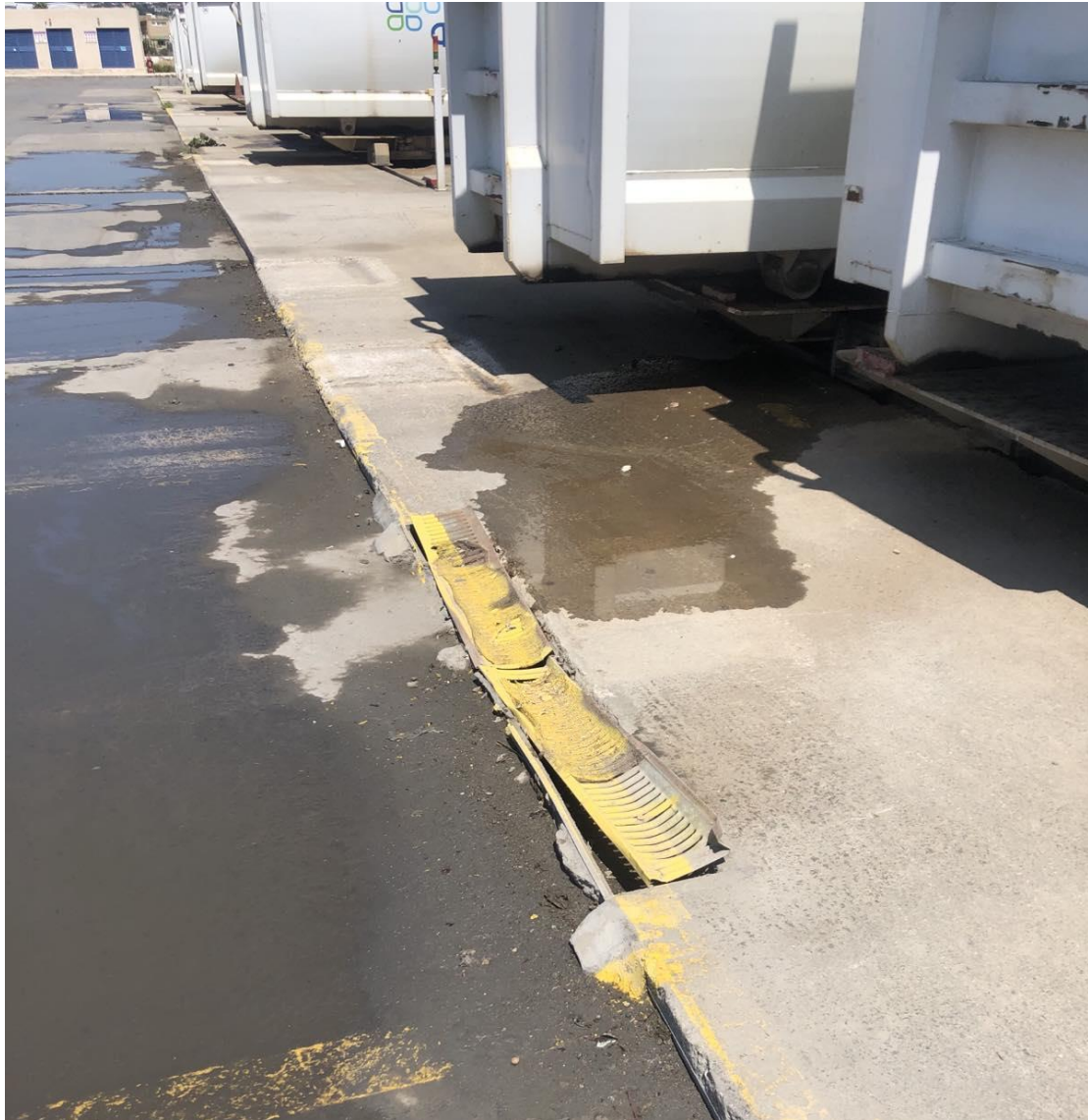
Εικόνα 2.3 Λήψη από την περιοχή έμπροσθεν των χοανών, όπου τοποθετούνται εσχάρες αποχέτευσης ομβρίων υδάτων, που έχουν φθαρεί. Η πλειοψηφία των εσχάρων έχουν αντικατασταθεί στο πλαίσιο της πρόσφατης εργολαβίας για την τοποθέτηση Μονάδας Προεπεξεργασίας Λυμάτων στον ΣΜΑ Ευκαρπίας.
