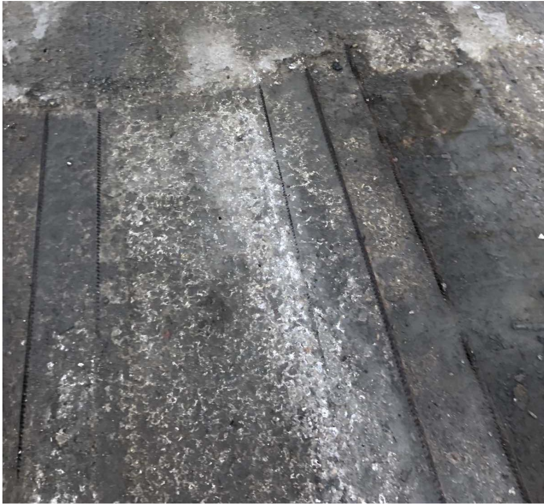
Εικόνα 2.8 Λήψη επί της πλάκας έδρασης των container. Σε αρκετές θέσεις έχει εμφανιστεί ο οπλισμός της άνω παρειάς της, με αποτέλεσμα την οξείδωσή του που εξελίσσεται με την πάροδο του χρόνου με ό,τι αυτό συνεπάγεται για την αντοχή του.
