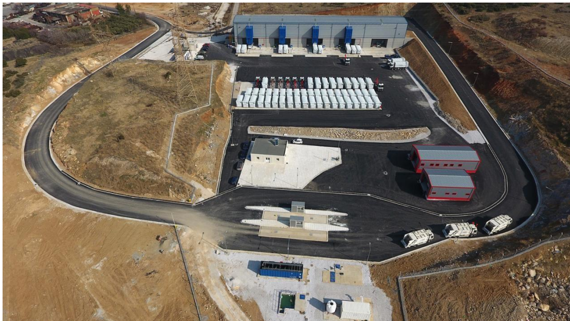
Εικόνα 2.1 Πανοραμική άποψη του ΣΜΑ Ευκαρπίας. Στο βάθος χωροθετούνται οι χοάνες, στα αριστερά οι πυλώνες του ΔΕΔΔΗΕ, ενώ έμπροσθεν αυτών και στο μέσο της εικόνας διακρίνεται ο χώρος αποθήκευσης των container απορριμμάτων, ο οποίος, όπως αναλύεται στη συνέχεια, παρουσιάζει διάφορα θέματα παθολογίας.
