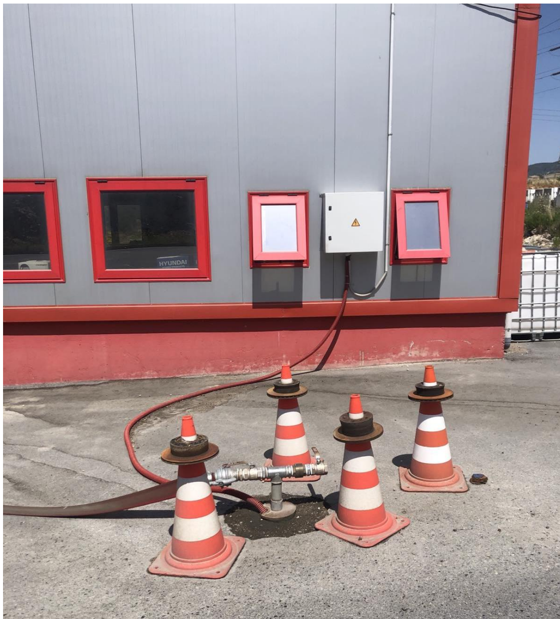
Εικόνα 2.4 Η θέση της υφιστάμενης (προσφάτως διανοιχθείσας) γεώτρησης. Διακρίνεται το λάστιχο πλήρωσης της υδροφόρας που λειτουργεί με χειροκίνητη εκκίνηση της λειτουργίας της υποβρύχιας αντλίας. Στα δεξιά, διακρίνεται η θάνα και η υποδοχή για την εγκατάσταση αγωγού μεταφοράς του αντλούμενου νερού στην υφιστάμενη δεξαμενή νερού-πυρόσβεσης.
