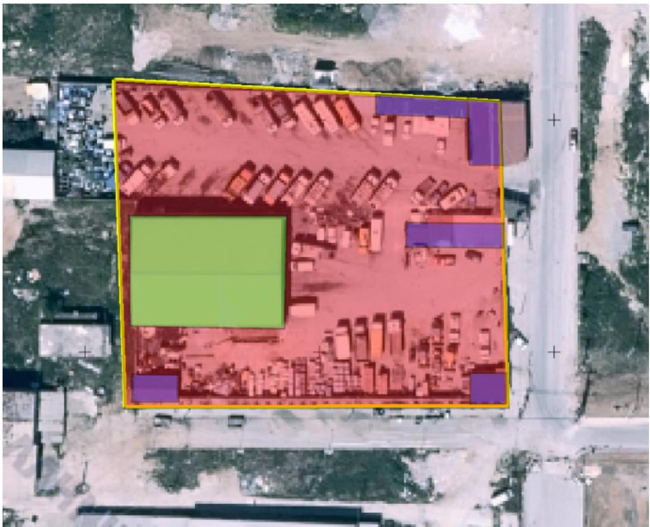
Εικόνα 7 Αμαξοστάσιο Δ. Κορδελιού - Ευόσμου. Με κόκκινο χρώμα απεικονίζεται το οικοπέδο, με μπλέ χρώμα τα κτήρια, και με πράσινο χρώμα το κτήριο του γυμναστηρίου που δεν λειτουργεί.
