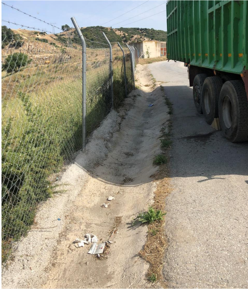
Εικόνα 2.8 Η υφιστάμενη τάφρος αποχέτευσης ομβρίων υδάτων που διατρέχει τον ΣΜΑ στο Βόρειο και στο Δυτικό τμήμα περιμετρικά αυτού.
