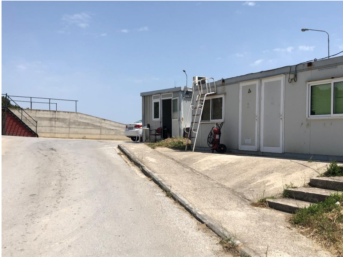
Εικόνα 2.14 Κατά μήκος της ράμπας που οδηγεί στο υψηλότερο επίπεδο έχουν τοποθετηθεί δύο (2) προκατασκευασμένοι οικίσκοι (container)
