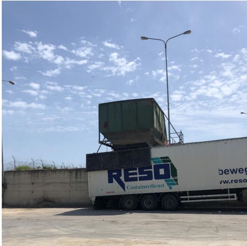
Εικόνα 2.20 Άποψη της περιοχής της πλατείας ελιγμών του ΣΜΑ Ιερισσού. Όπισθεν του οχήματος διακρίνεται το τοίχείο αντιστήριξης του δεύτερου (ψηλότερου) επιπέδου του ΣΜΑ, στο οποίο παρουσιάζονται ίχνη υγρασίας τόσο στη στέψη όσο και στη βάση του.
