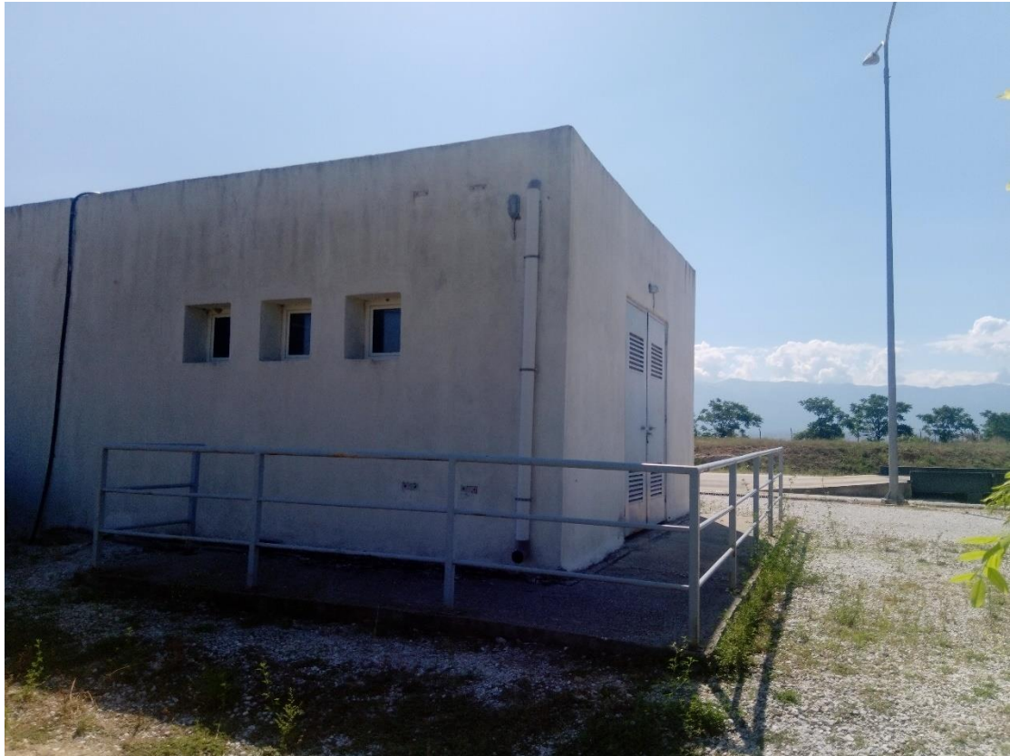
Εικόνα 2-24 Η οπίσθια όψη της δεξαμενής νερού-πυρόσβεσης. Διακρίνεται ο ξηρός θάλαμος του αντλιοστασίου με τα ορθογωνικά ανοίγματα. Στα αριστερά διακρίνεται ο υγρός θάλαμος της δεξαμενής.
