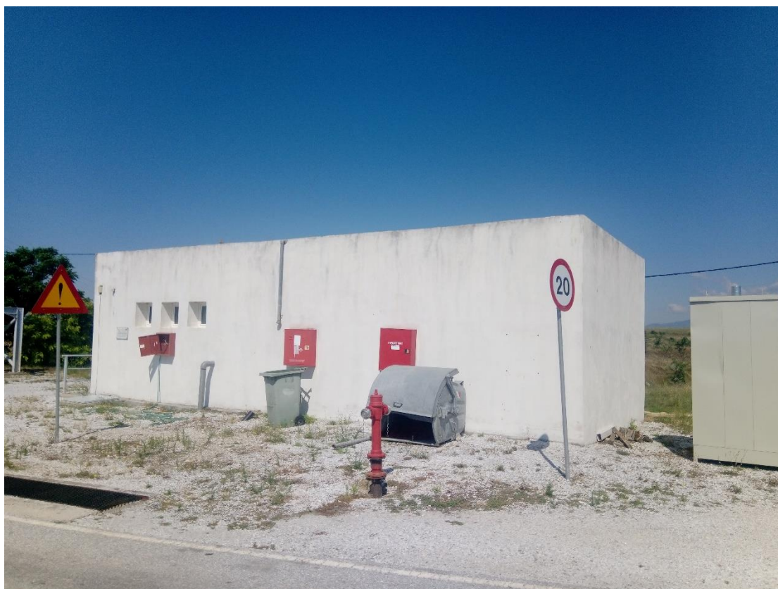
Εικόνα 2-23 Εμπρός της όψης της δεξαμενής νερού (δεξιά της φωτο). Διακρίνονται η εσχάρα του καναλιού αποστράγγισης ομβρίων υδάτων που διέρχεται έμπροσθεν αυτής. Διακρίνεται επίσης ο ξηρός θάλαμος του αντλιοστασίου στα αριστερά με τα ορθογωνικά ανοίγματα.
