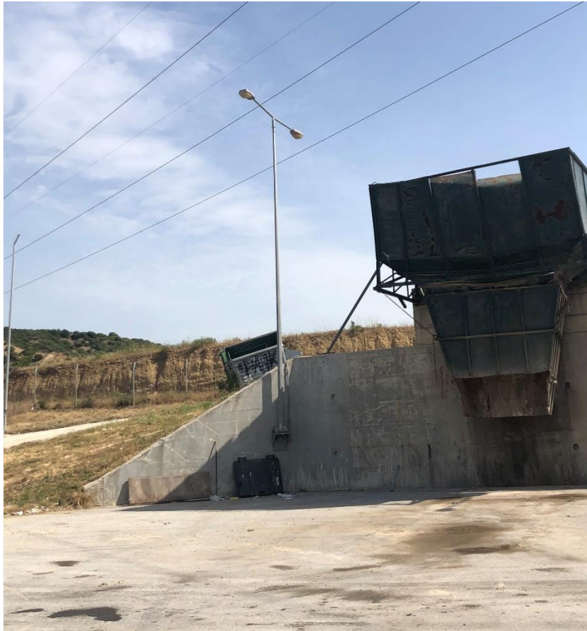
Εικόνα 2.6 Άποψη της περιοχής της 3ης (κατά σειρά) χοάνης του ΣΜΑ. Διακρίνονται επιφανειακές φθορές της πλατείας ελιγμών του Σταθμού
