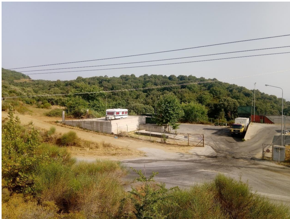
Εικόνα 2.12 Λήψη απέναντι από την είσοδο του ΣΜΑ, στην οποία διακρίνονται η σκουριασμένη είσοδος του ΣΜΑ, η ράμπα που οδηγεί στο υψηλότερο επίπεδο στο οποίο ανέρχονται τα απορριμματοφόρα για την απόρριψη του φορτίου τους μέσω της χοάνης απόρριψης στο κατώτερο επίπεδο.
