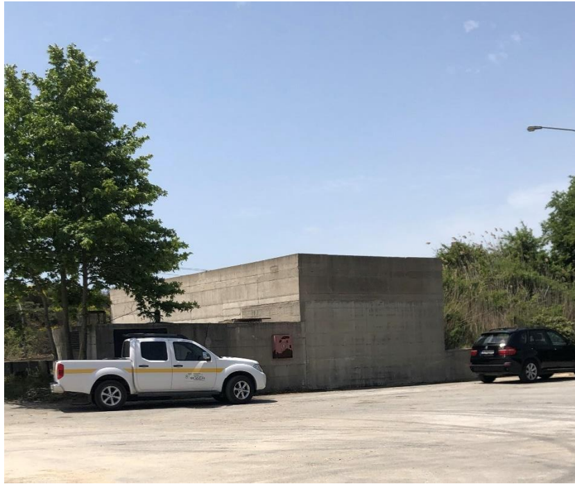
Εικόνα 2.16 Το υφιστάμενο αντλιοστάσιο πυρόσβεσης στα αριστερά, επί του τοιχείου του οποίου διακρίνεται η πυροσβεστική φωλιά. Το ψηλότερο κτίσμα πλησίον του αντλιοστασίου είναι η δεξαμενή νερού.
