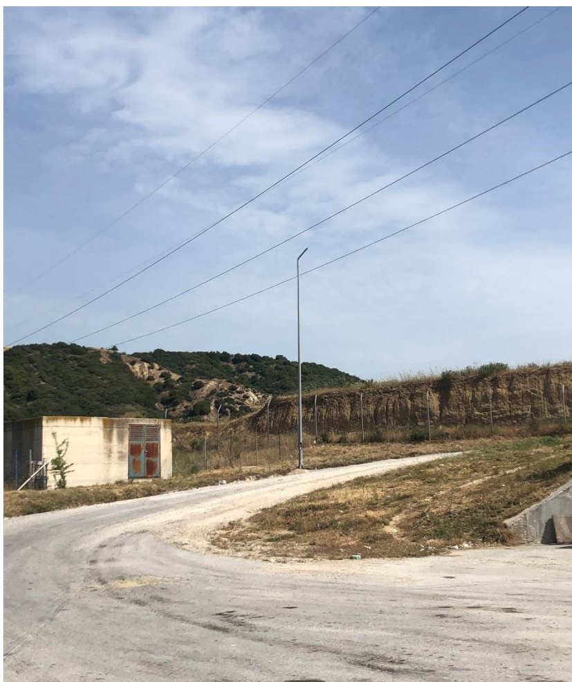
Εικόνα 2.3 Η εσωτερική οδός του ΣΜΑ που οδηγεί στην πλατεία αυτού. Διακρίνεται το αντλιοστάσιο πυρόσβεσης (δεξαμενή νερού) στα αριστερά και η απουσία φωτιστικού σώματος από τον ιστό οδοφωτισμού στη μέση της φωτογραφίας.
