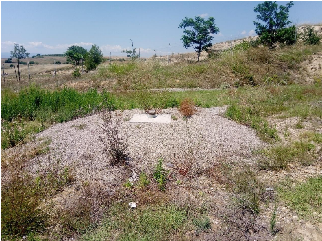
Εικόνα 2-21 Η θέση της γεώτρησης στο Νότιο Τμήμα του ΣΜΑ Ζίχνης
