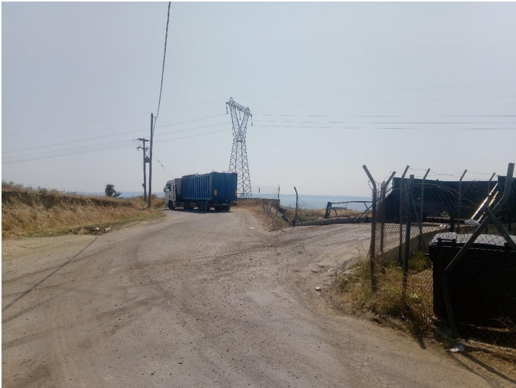
Εικόνα 2.1 Λήψη από την είσοδο του ΣΜΑ με κατεύθυνση την οδό πρόσβασης σε αυτόν. Στα δεξιά διακρίνεται η πρώτη ράμπα και στο βάθος η πρώτη χοάνη απόρριψης.
