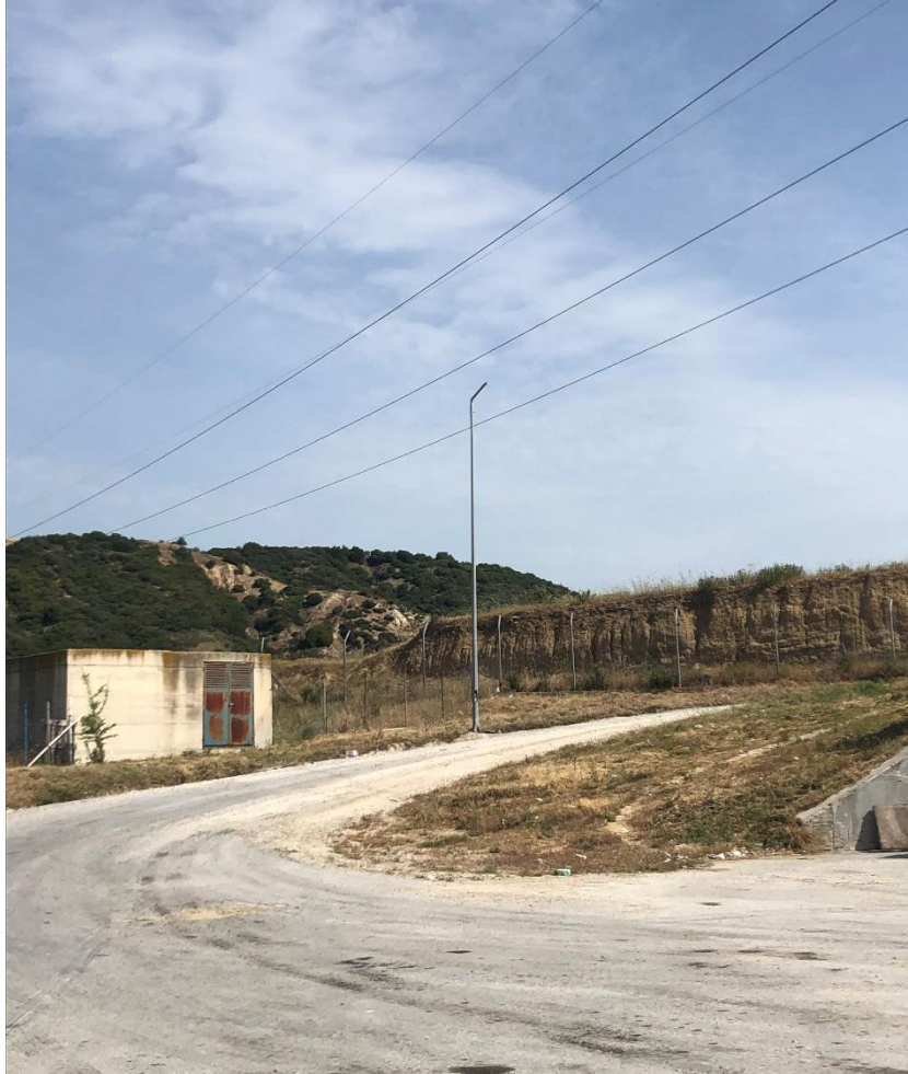
Εικόνα 2.3 Η εσωτερική οδός του ΣΜΑ που οδηγεί στην πλατεία αυτού. Διακρίνεται το αντλιοστάσιο πυρόσβεσης (δεξαμενή νερού) στα αριστερά και η απουσία φωτιστικού σώματος από τον ιστό οδοφωτισμού στη μέση της φωτογραφίας.
