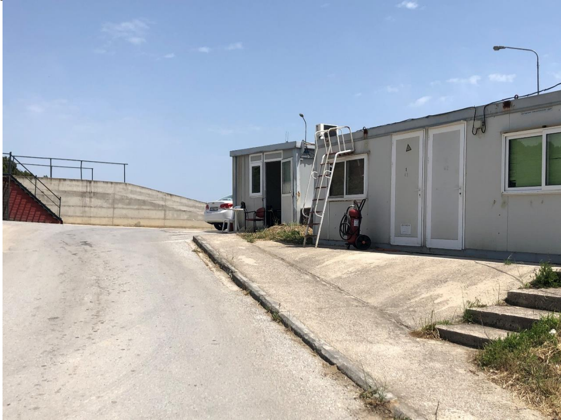
Εικόνα 2.3 Κατά μήκος της ράμπας που οδηγεί στο υψηλότερο επίπεδο έχουν τοποθετηθεί δύο (2) προκατασκευασμένοι οικίσκοι (container)
