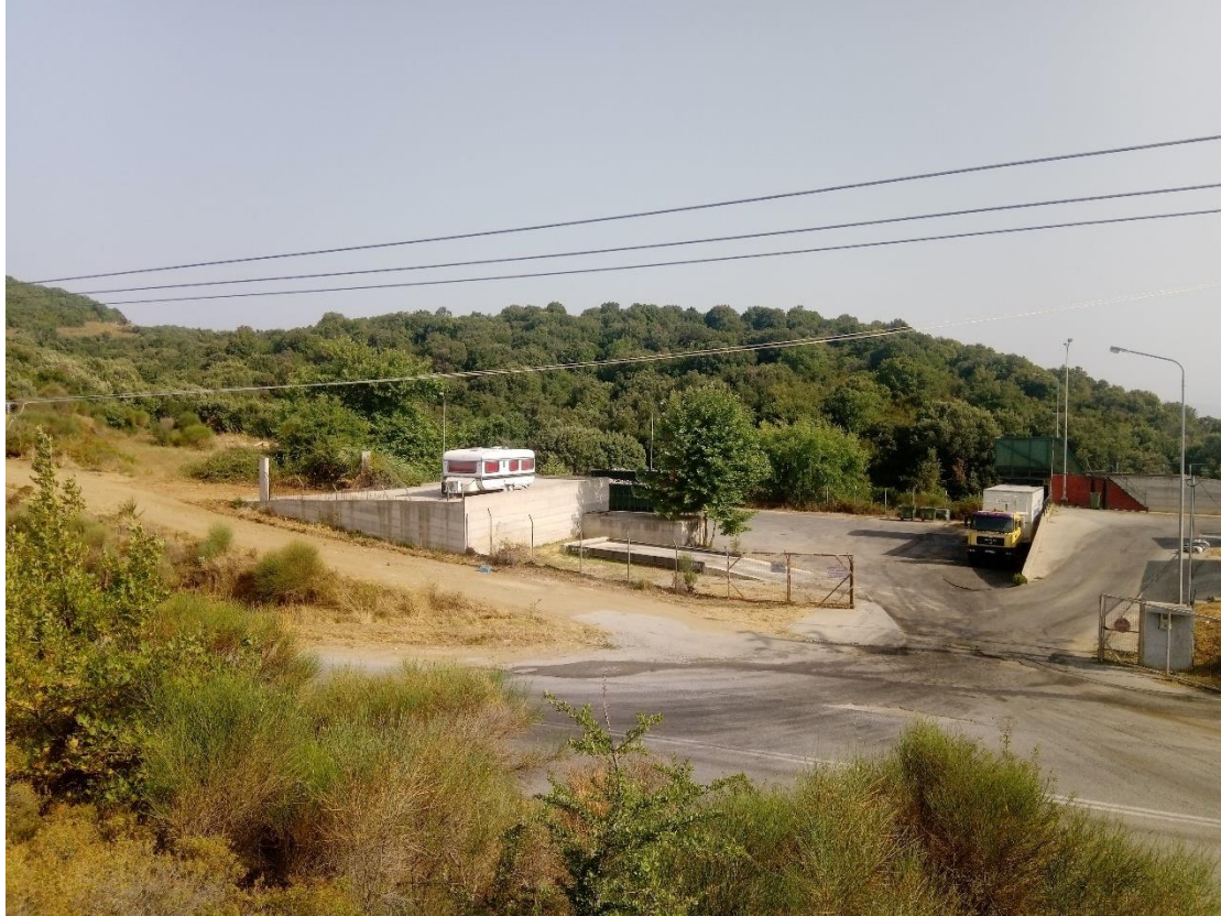
Εικόνα 2.1 Λήψη απέναντι από την είσοδο του ΣΜΑ, στην οποία διακρίνονται η σκουριασμένη είσοδος του ΣΜΑ, η ράμπα που οδηγεί στο υψηλότερο επίπεδο στο οποίο ανέρχονται τα απορριμματοφόρα για την απόρριψη του φορτίου τους μέσω της χοάνης απόρριψης στο κατώτερο επίπεδο.
