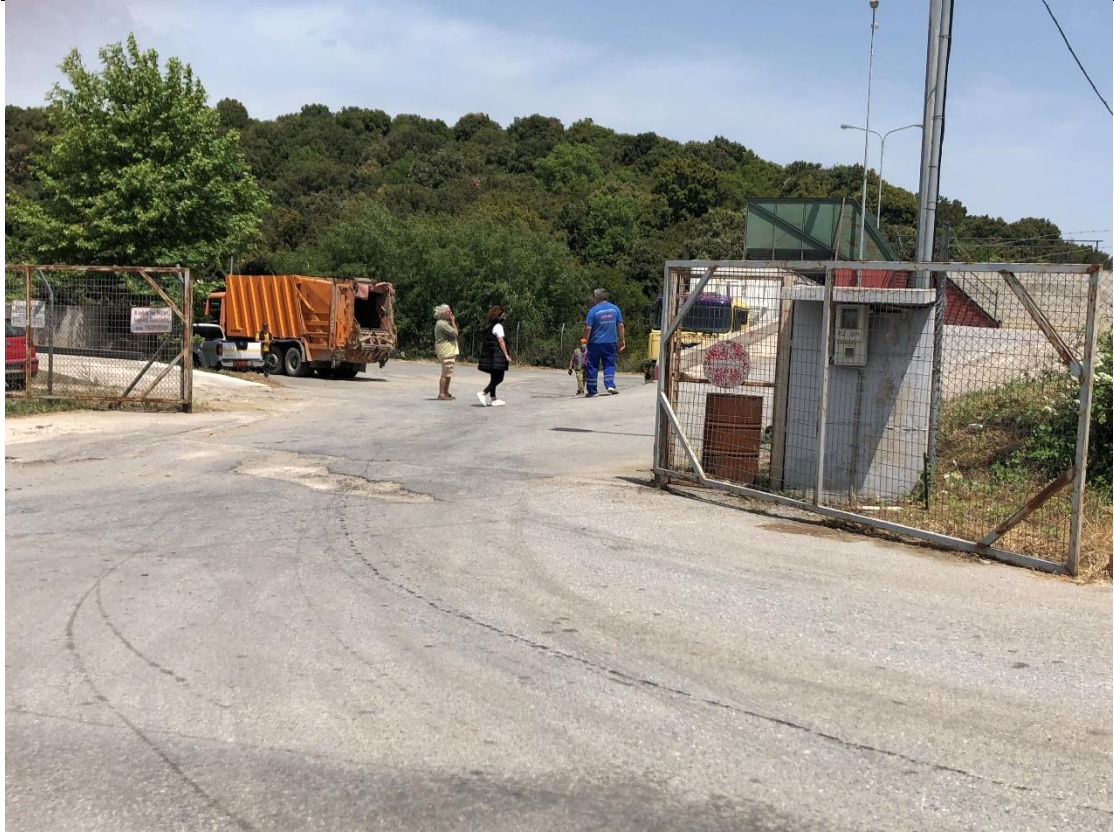
Εικόνα 2.2 Η υφιστάμενη φθαρμένη είσοδος του ΣΜΑ Ιερισσού. Μετά την είσοδο στον ΣΜΑ, στα δεξιά (και Ανατολικά του ΣΜΑ)
