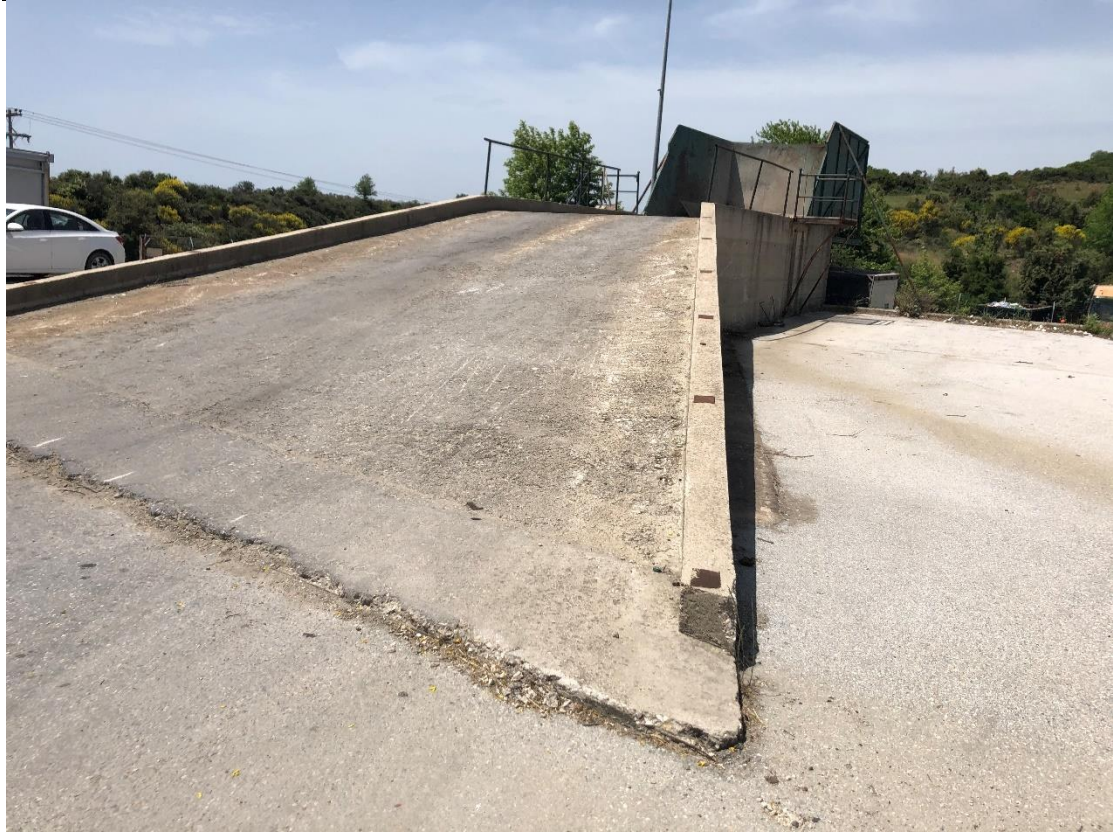
Εικόνα 2.4 Λήψη στη θέση της ανάπτυξης της χοάνης απόρριψης
