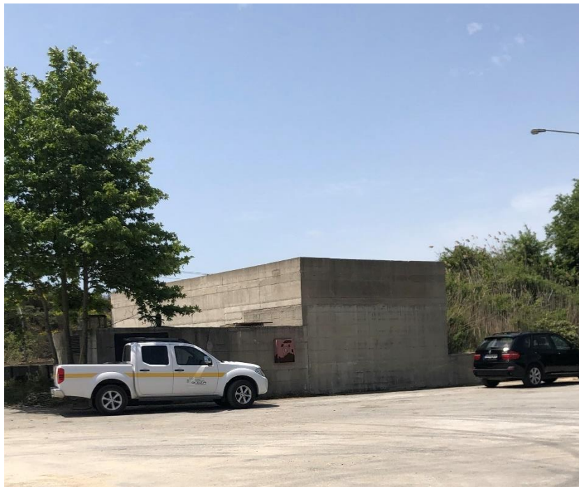
Εικόνα 2.5 Το υφιστάμενο αντλιοστάσιο πυρόσβεσης στα αριστερά, επί του τοιχείου του οποίου διακρίνεται η πυροσβεστική φωλιά. Το ψηλότερο κτίσμα πλησίον του αντλιοστασίου είναι η δεξαμενή νερού.
