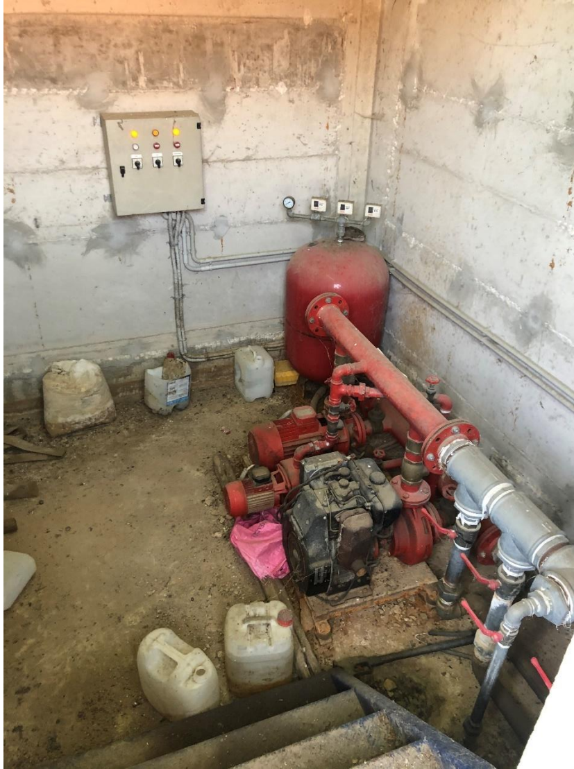
Εικόνα 2.6 Φωτογραφική λήψη από το εσωτερικό του αντλιοστασίου, το οποίο δεν έχει συνδεθεί με την δεξαμενή νερού πλησίον αυτού.
