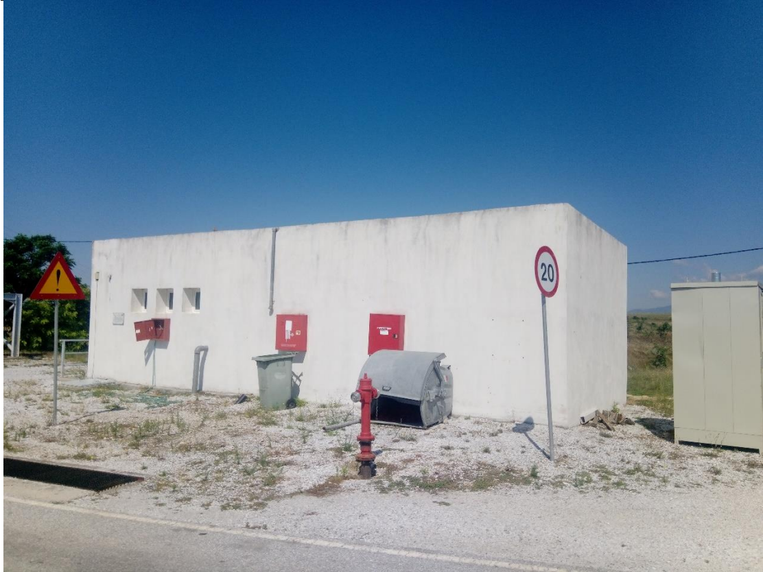
Εικόνα 2-3 Εμπρόσθια όψη της δεξαμενής νερού (δεξιά της φωτό). Διακρίνονται η εσχάρα του καναλιού αποστράγγισης ομβρίων υδάτων που διέρχεται έμπροσθεν αυτής. Διακρίνεται επίσης ο ξηρός θάλαμος του αντλιοστασίου στα αριστερά με τα ορθογωνικά ανοίγματα.
