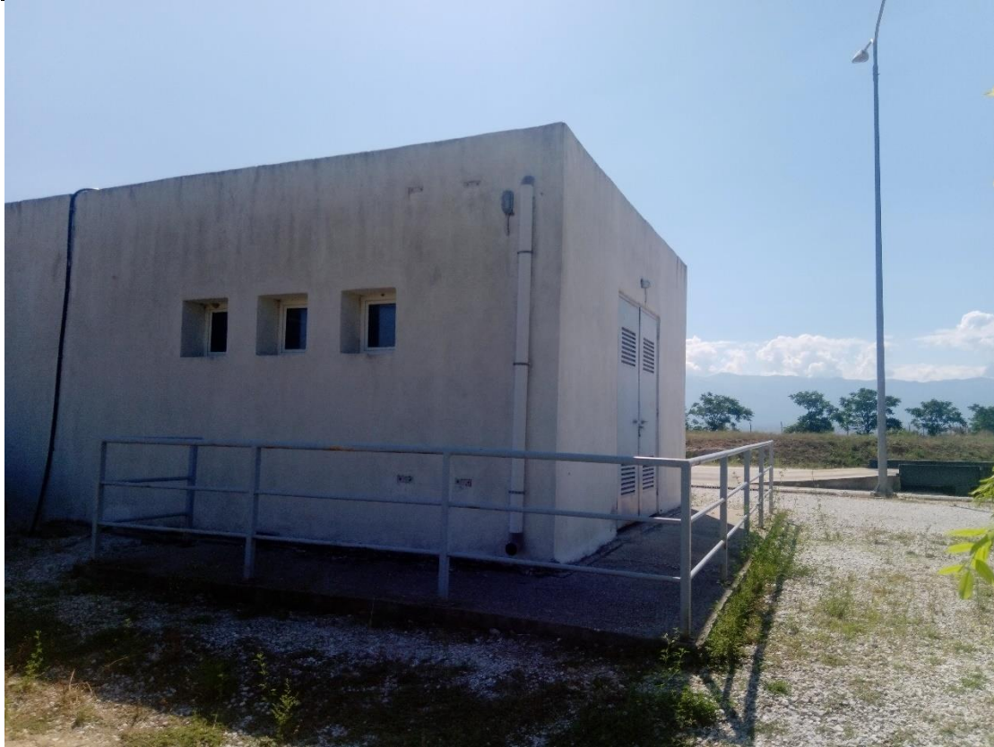
Εικόνα 2-4 Η οπίσθια όψη της δεξαμενής νερού-πυρόσβεσης. Διακρίνεται ο ξηρός θάλαμος του αντλιοστασίου με τα ορθογωνικά ανοίγματα. Στα αριστερά διακρίνεται ο υγρός θάλαμος της δεξαμενής.
