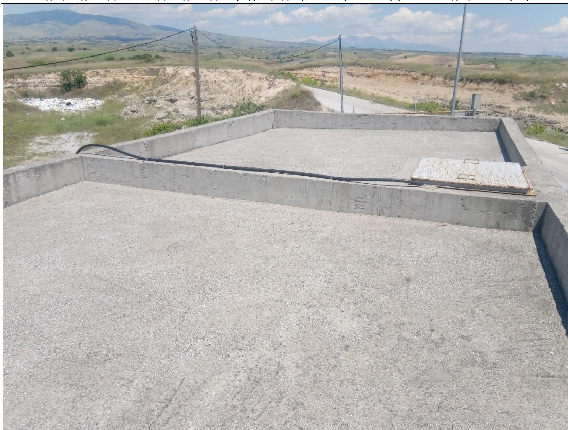
Εικόνα 2-6 Άποψη του δώματος της δεξαμενής νερού-πυρόσβεσης του ΣΜΑ Ζίχνης (υγρός θάλαμος αυτής)
