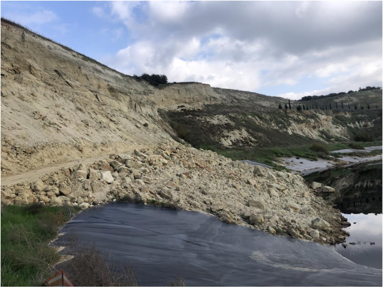
Εικόνα 4 Κοντινότερη άποψη των χωματισμών του υφιστάμενου πρανούς, στην οποία διακρίνεται η προσωρινή χωμάτινη οδός που έχει διαμορφωθεί για την εξυπηρέτηση της κυκλοφορίας περιμετρικά της λιμνοδεξαμενής.
