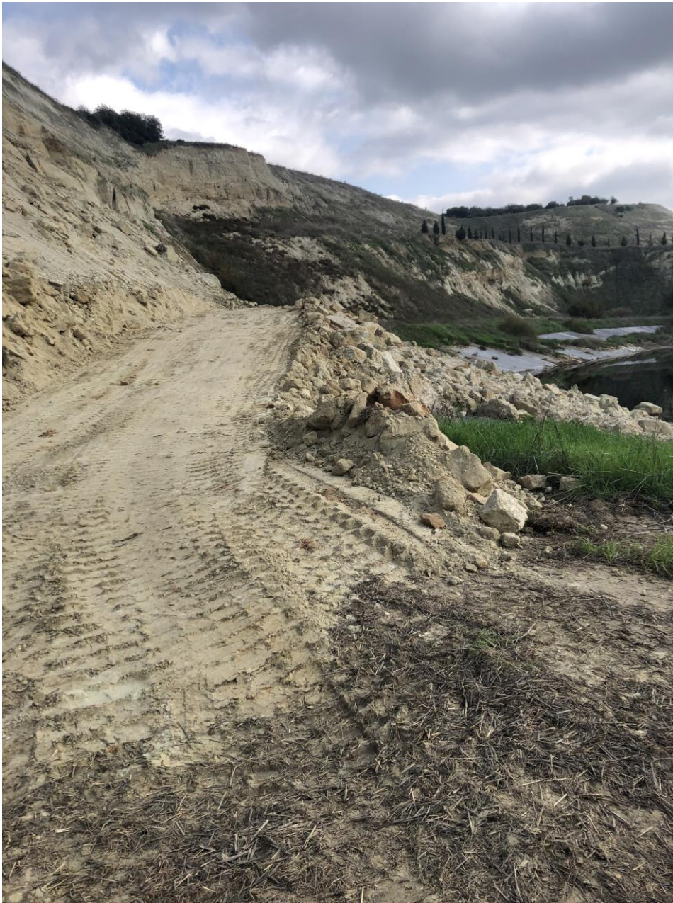
Εικόνα 5 Άποψη της χωμάτινης οδού που διαμορφώθηκε στη θέση αστοχίας του Βόρειου πρανούς. Η οδός κινείται σε επίχωμα το οποίο λειτουργεί εν είδει αντιβάρου στο κατολισθήσαν πρανές.
