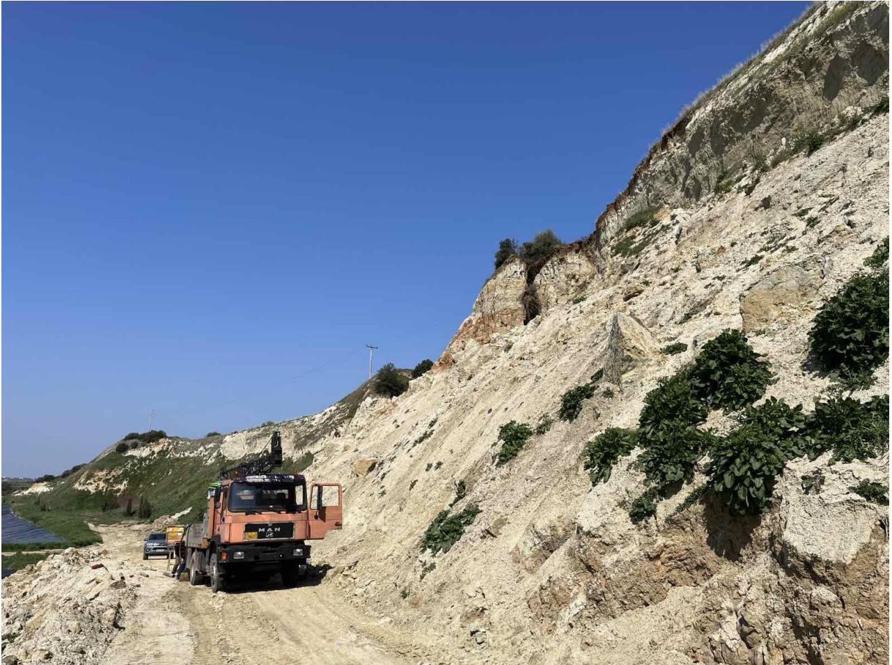
Εικόνα 8 Θέση υλοποίησης της δειγματοληπτικής γεώτρησης Γ1 Βάθους 20,0m. Διακρίνεται ο εξοπλισμός και το γεωτρήπανο με κατεύθυνση προς τα Δυτικά.
