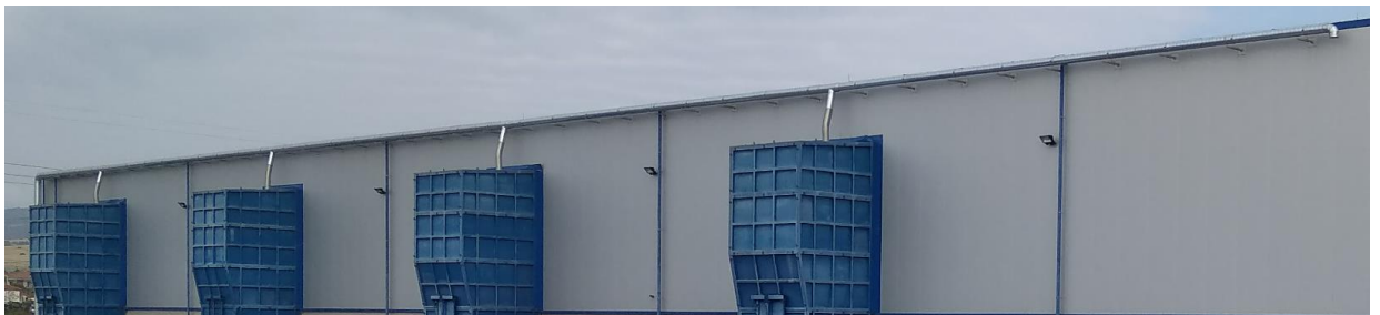
Εικόνα 3. Κοινό σύστημα αναρρόφησης αέρα από χοάνες
