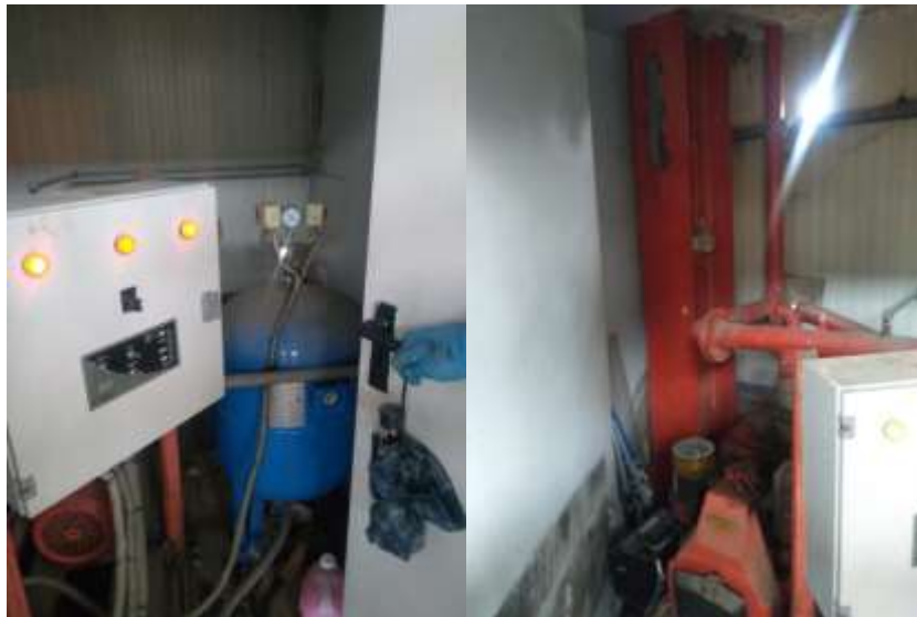
Εικόνες 5,6 Πυροσβεστικό συγκρότημα του ΚΔΑΥ Ταγαράδων και η μπαταρία
