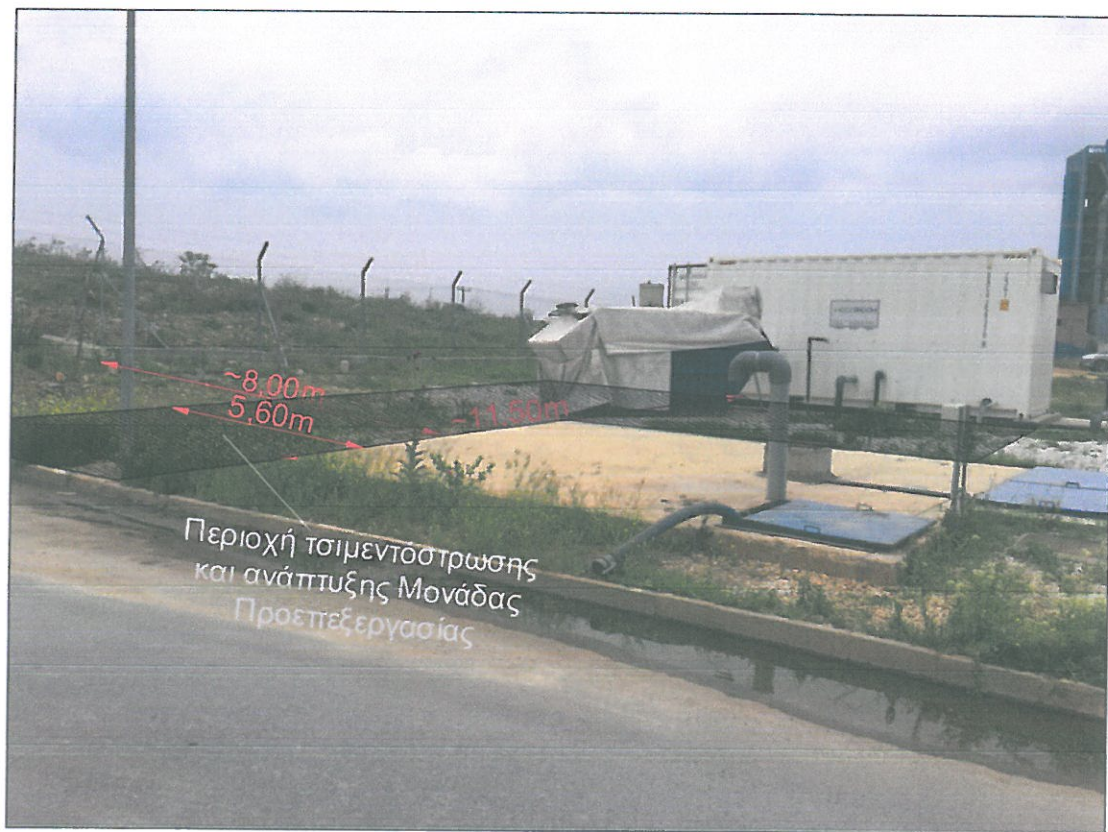
Εικόνα 3 Άποψη της περιοχής της Δεξαμενής Εξισορρόπησης με ενδεικτικές αποστάσεις από κοντινές κατασκευές στην περιοχή των έργων ανάπτυξης της Μονάδας Προεπεξεργασίας. Από την εικονιζόμενη περιοχή θα διέρχεται ο αγωγός μεταφοράς λυμάτων-στραγγισμάτων, ο οποίος θα οδηγεί τα λύματα-στραγγίσματα στο φρεάτιο συγκέντρωσης αυτών. Η περιοχή θα τσιμεντοστρωθεί όπως παρουσιάζεται στα συνημμένα σχέδια.
