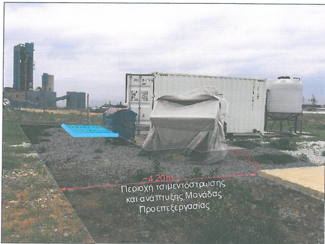
Εικόνα 4 Άποψη της περιοχής ανάπτυξης των έργων της Μονάδας Προεπεξεργασίας Λυμάτων-Στραγγισμάτων. Η περιοχή που διακρίνεται θα τσιμεντοστρωθεί για απόσταση περίπου 4,20m από τη Δεξαμενή Εξισορρόπησης. Με γαλάζιο χρώμα διακρίνεται η θέση του φρεατίου συγκέντρωσης λυμάτων-στραγγισμάτων, από το οποίο αυτά, μέσω μίας έλικας Αρχιμήδη θα οδηγούνται στη Μονάδα Προεπεξεργασίας.
